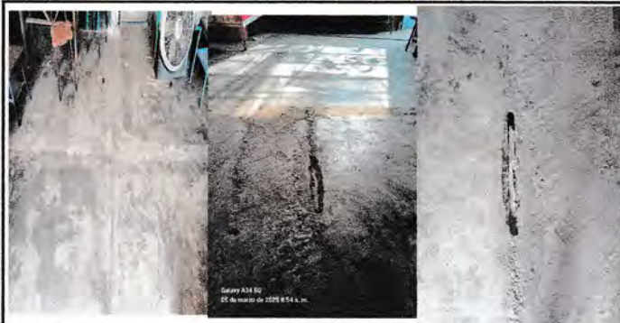
Foto 6: Torta de cemento en el area de la dirección, se encuentra rajado y rústico por el paso del tiempo, además hay una parte rustica por levantamiento de torta.
