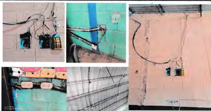
Foto 5: Cables electricos y flípones mal conetados, los cuales son los que alimentan toda la escuela, ubicados en la dirección. Además tomacorrientes sin tapadera y alambres pelados, en varios salones de clase. Es un riesgo para los estudiantes.
